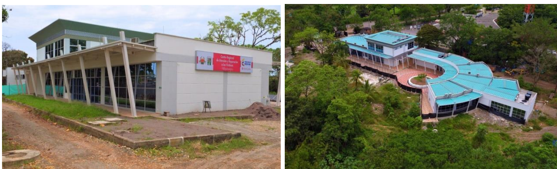
Figura 10. Registro fotográfico estado de la obra centro de atención y reparación a víctimas regional – Villavicencio:
