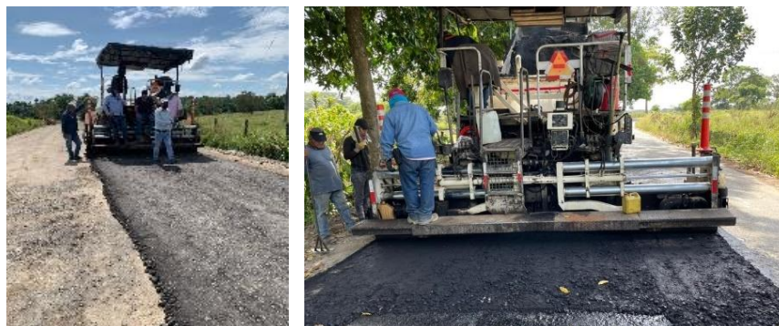
Figura 8. Registro fotográfico de la obra Mejoramiento de la Vía Trocha 7 en Fuente de Oro y Puerto Lleras:
