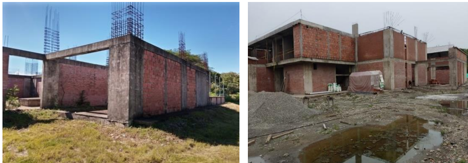
Figura 9. Registro fotográfico Construcción del punto de atención integral a las víctimas – Granada:
