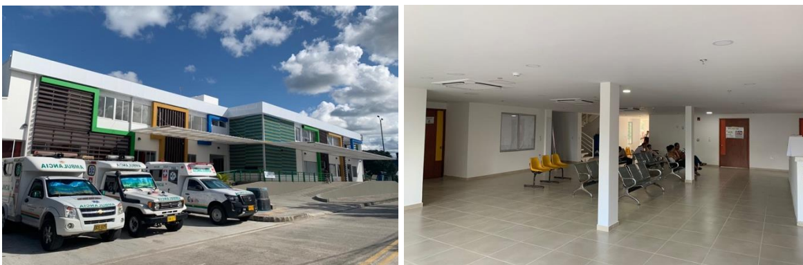
Figura 11. Registro fotográfico de la obra infraestructura Física del Hospital Local de Guamal.
