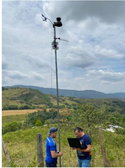
Figura 3. Instalación de una estación meteorológica
