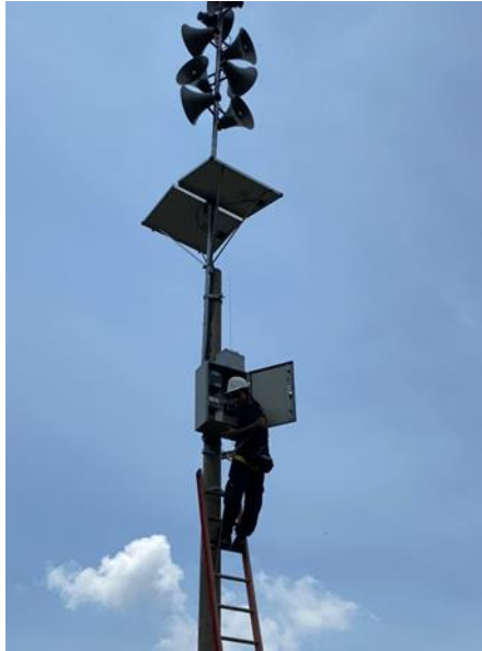
Figura 5. Instalación de torres autónomas de sirenas de alerta
