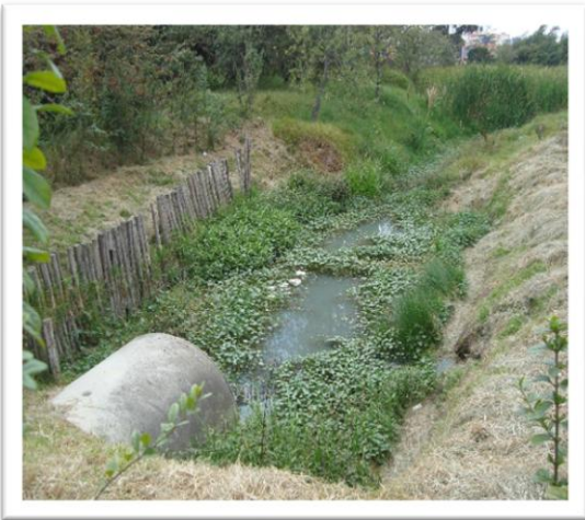
Foto 36. Conexión con el canal de los ángeles.
