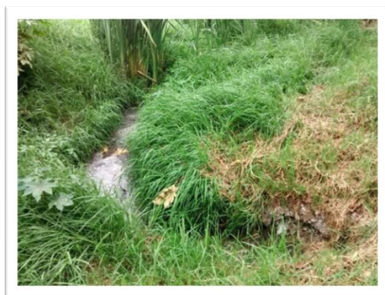
Foto 34. Conexión ilegal. Fuente: Elaboración propia.
