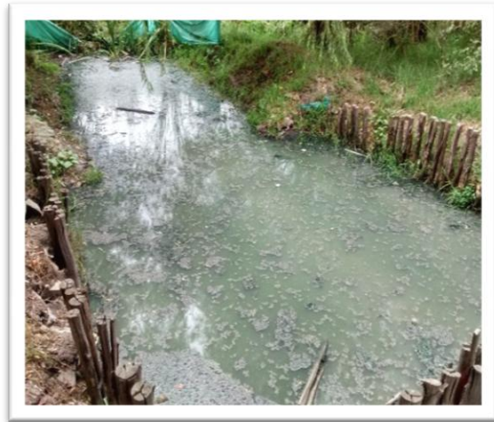
Foto 37. Biofiltro natural en construcción.
