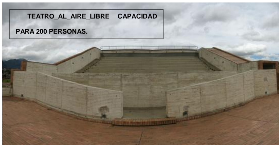
Figura 21. Espacios externos Biblioteca Virgilio Barco - archivo de la Biblioteca
