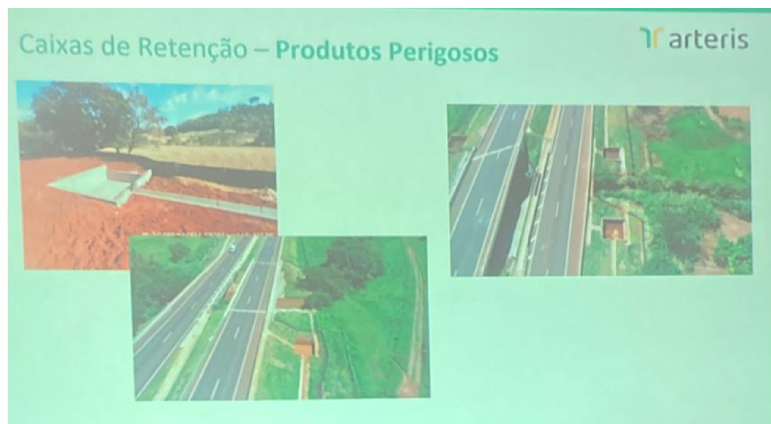
Ilustración 3 Cajas de retención de residuos peligrosos en la vía Paulista, Brasil. Fuente: Concesionaria Arteris.
