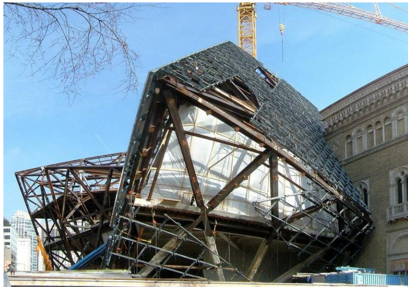
Imagen 30. Detalle estructural. Ampliación del
