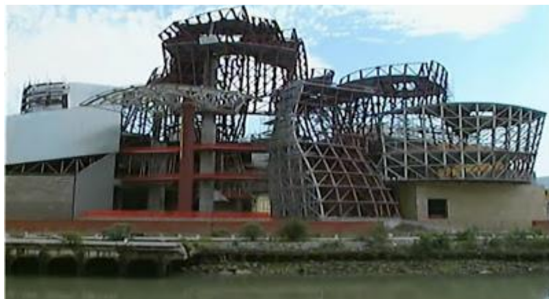
Imagen 13. Armazón estructural de acero Museo Guggenheim
