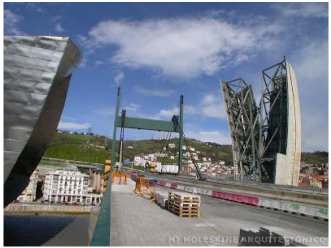
Imagen 14. . Costado del Puente de la Salve
