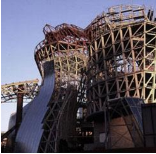
Imagen 15. Recubrimiento metálico Museo Guggenheim
