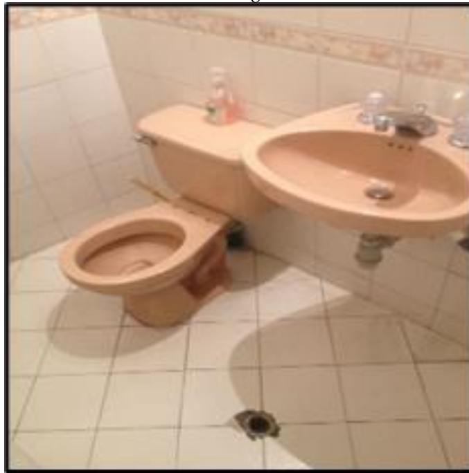
Figura 9. Unidades sanitarias CEAD Bucaramanga.
