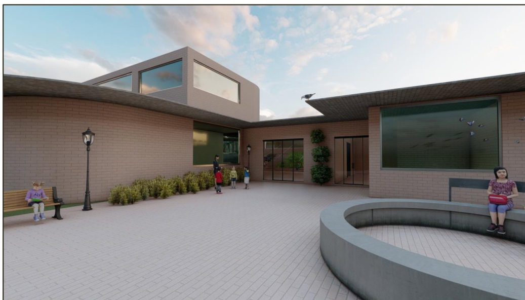
Imagen 52. Plazoleta de acceso
