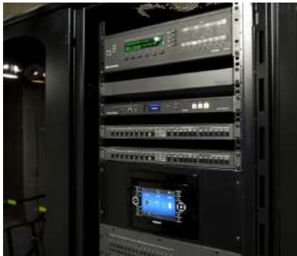
Figura 8. Equipos Core del auditorio, Cerebro y pantalla de control. Fuente http://www.crestron.com.mx/casosdeexito/biblioteca.php
