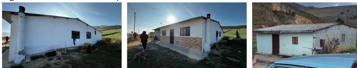
Fotografías tomadas en sitio
