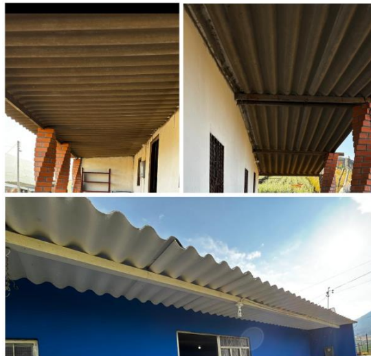
Figura 80. Cubierta de las viviendas estudiadas.
