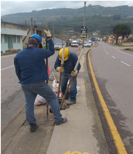
Figura 13. Excavación del Hoyo
