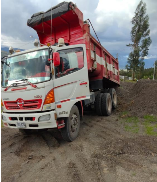
Figura 11. Transporte de material granular asfáltico
