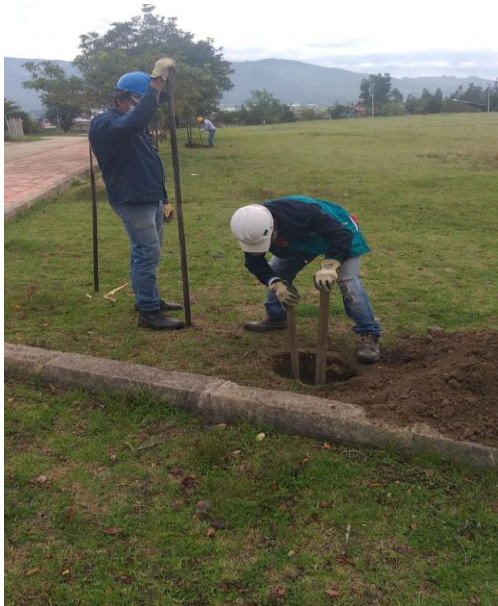
Figura 15. Verificación profundidad del Hoyo
