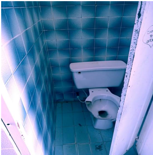
Figura 25. Supervisión de Sanitarios.
