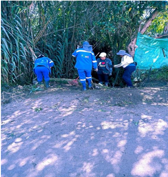
Figura 19. Limpieza de Quebradas
