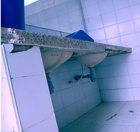
Figura 28. Toma de cantidades de Lavamanos
