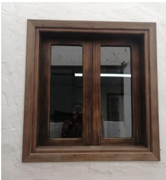
Figura 3. Instalación Ventana de Madera
