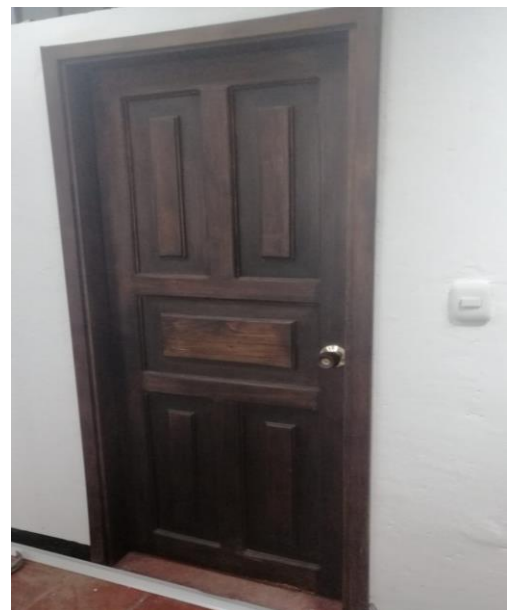
Figura 4. Instalación Puerta de Madera
