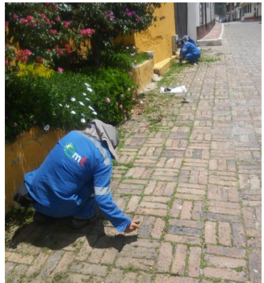
Figura 22. Limpieza de Adoquín
