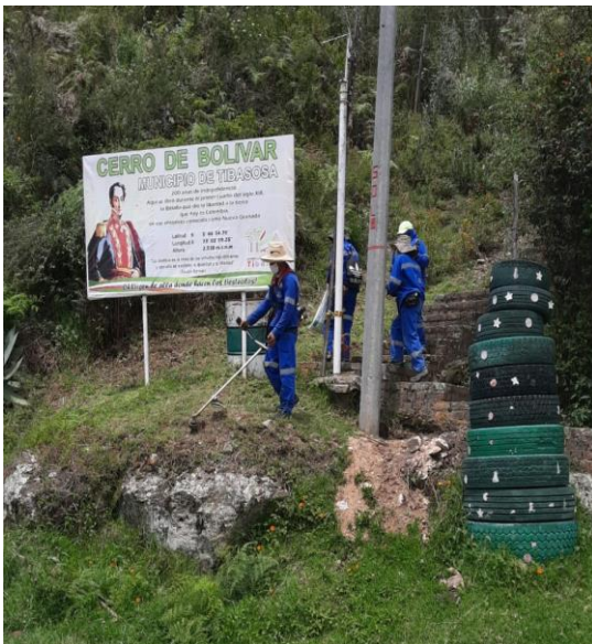
Figura 20. Mantenimiento cerro de Bolívar
