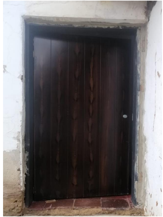
Figura 6. Instalación Puerta en Pasillo
