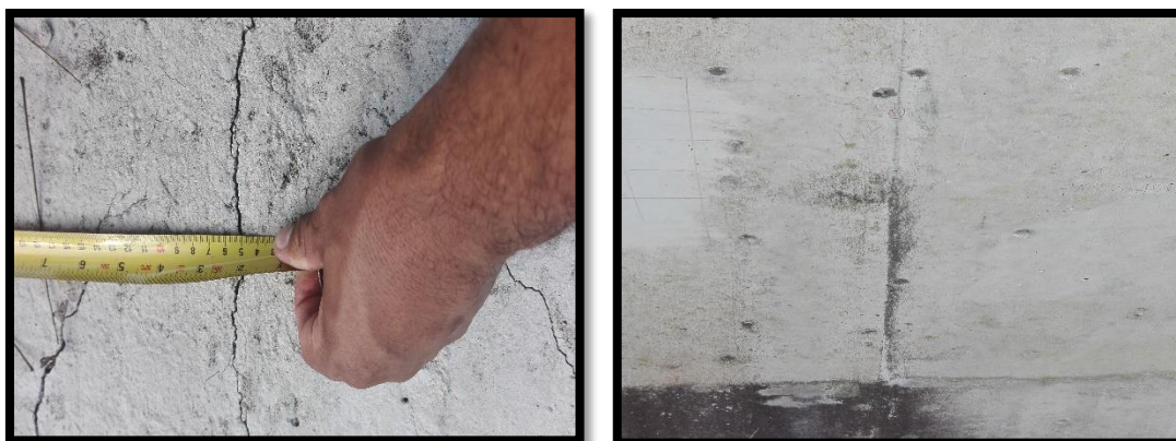
Fotografía 25,26,27,28. Tanque No. 17 Tipo 1 Sector Santa Helena II
