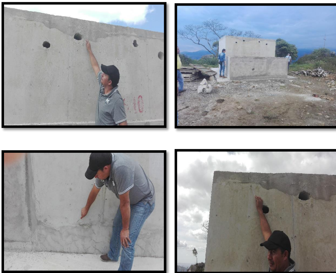
Fotografía 1,2,3,4. Tanque No. 10 tipo 1 sector piedra ancha (piedra blanca)
