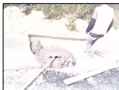
Obra de drenaje
