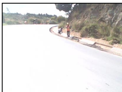
Fraguado concreto hidráulico
