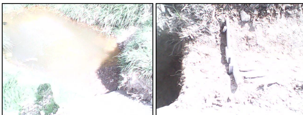
Ilustración 16. La excavación de la alcantarilla se encuentra inundada
