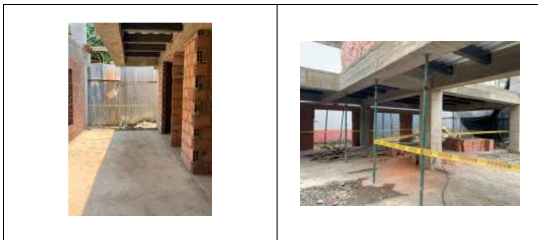
Ilustración 11. Señalización de obra y demarcación de visita segura
