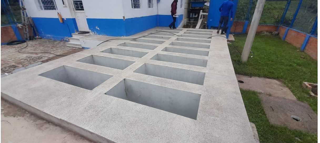
Ilustración 10. Inspección rutinaria al sedimentador
