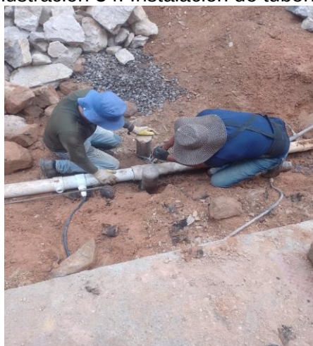
Ilustración 34. Instalación de tubería
