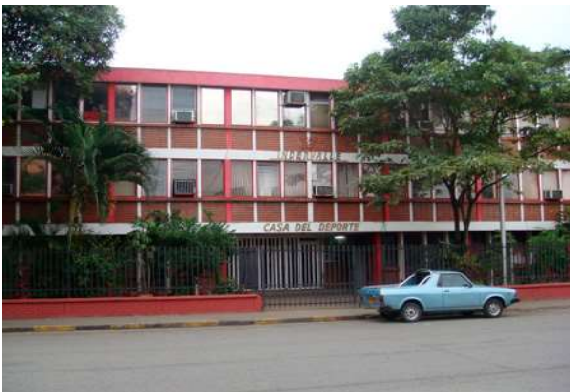
Ilustración 1. Fachada Principal - foto antigua.
