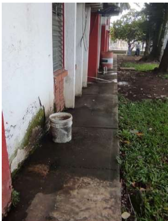
Ilustración 15. Lesión Humedad por microcapilaridad en fachada (HM1). Fuente: los autores.
