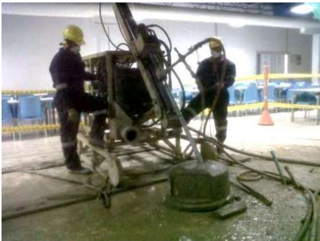
Ilustración 42. Inyecciones de lechada. Fuente: http://suelos.dakia.co/index.php/experiencia/construccion
