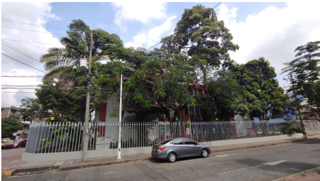
Ilustración 31. Fachada Sur-oriental vista desde el otro lado de la calle 5B4. Fuente. Los autores.
