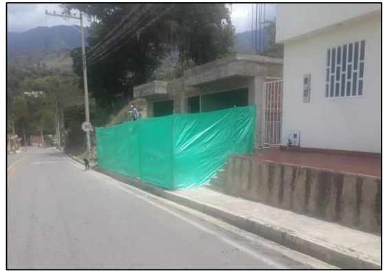
Figura 21: Encerramiento construcción Fuente: Autor
