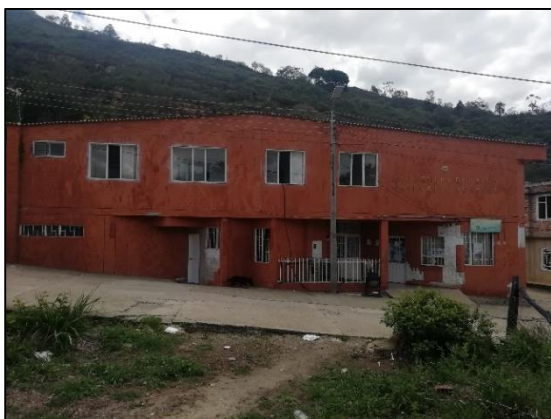
Figura 27: Fachada frontal (oriente) Fuente: Autor
