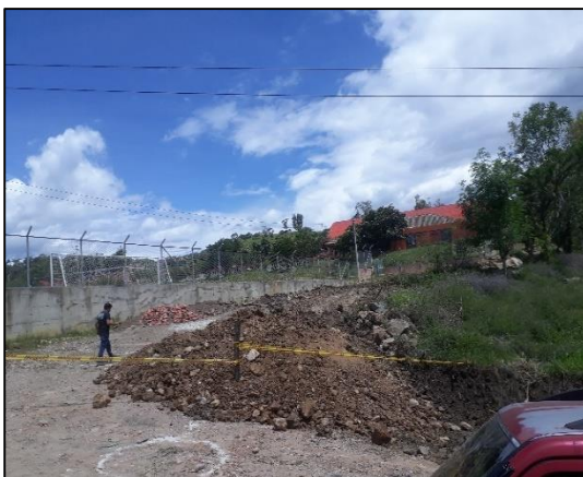
Figura 42: Demarcación Pozo 3 Fuente: Autor
