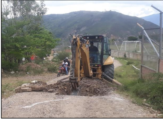
Figura 38: Excavación pozo 1 Fuente: Autor
