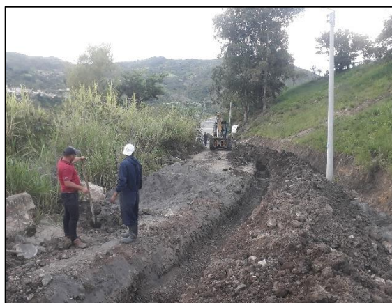
Figura 45: Tramo 5-6 Final red instalada Fuente: Autor
