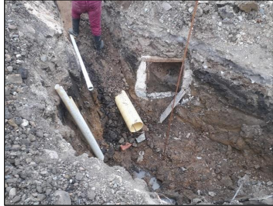
Figura 41: Pozo 2 tramo 1-2 completado Fuente: Autor
