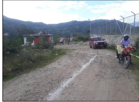
Figura 39: Demarcación pozo 2 Fuente: Autor
