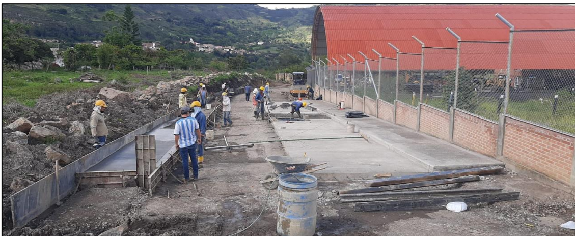
Figura 48: Inicio ejecución contrato LP 001 de 2018 Fuente: Autor
