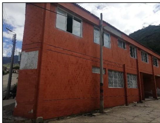
Figura 28: Fachada lateral (norte) Fuente: Autor
