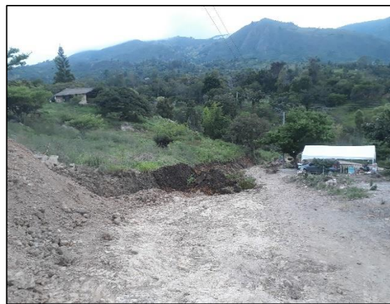
Figura 43: Perfilamiento de talud Fuente: Autor
