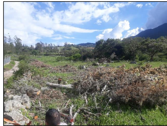
Figura 14: Ejecución del aprovechamiento Fuente: Autor
