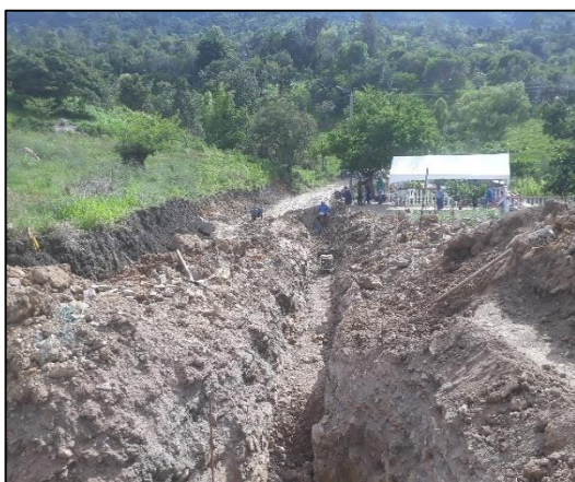
Figura 44: Tramo 3-4 Red instalada Fuente-. Autor
