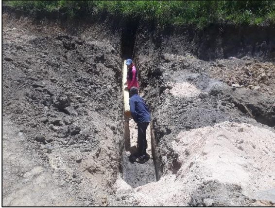
Figura 46: Instalación de acometidas Fuente: Autor
