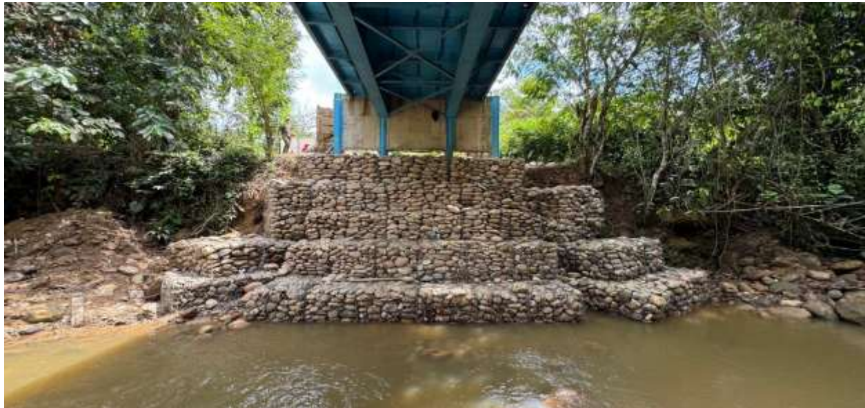
Figura 9. Muro de contención tipo gaviones en su etapa final
