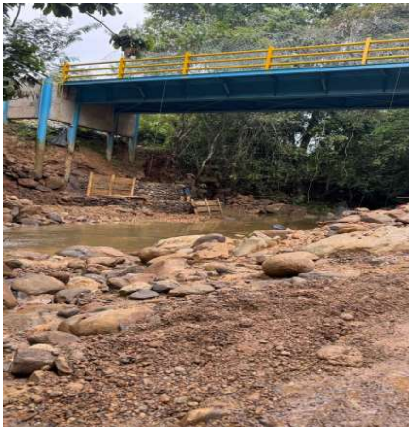
Figura 8. Muro de contención tipo gaviones en la primera semana de inicio.
