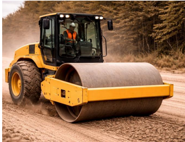
Figura 22. Rodillo vibratorio moderno
