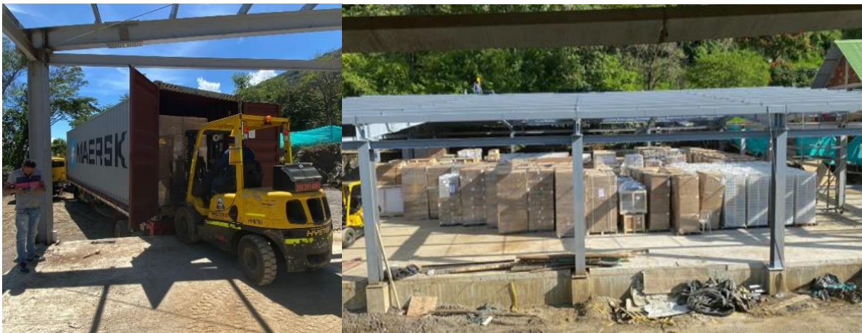
Figura 10. Finalización descargue de 6 contenedores, ampliación planta San Gil.
