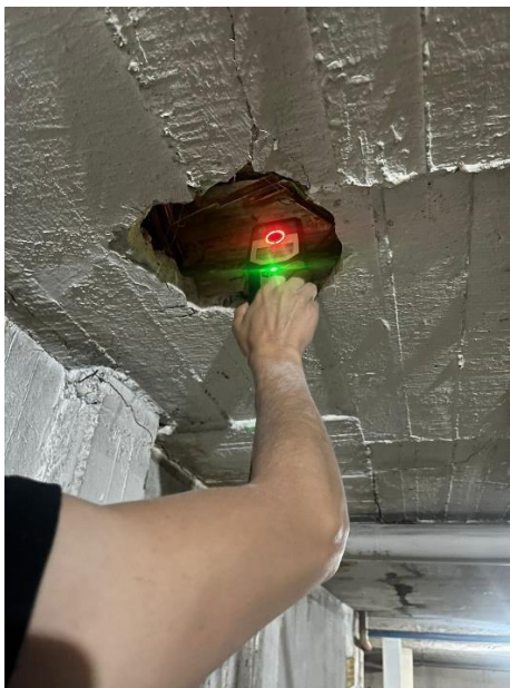
Figura 7. Escáner en viga
