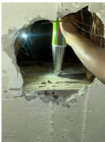
Figura 6. Toma de esclerómetro placa entre piso
