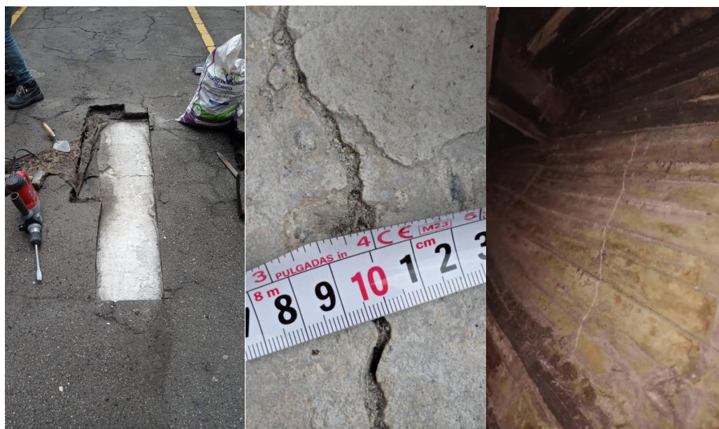
Figura 15.a Auscultación de vigas placa entre piso
