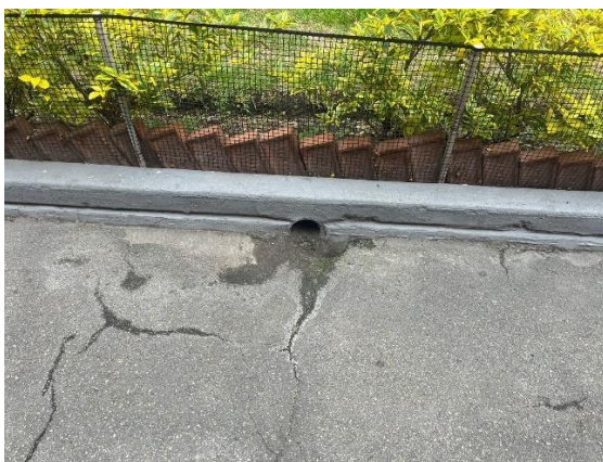
Figura 5. Pavimento placa de entre piso
