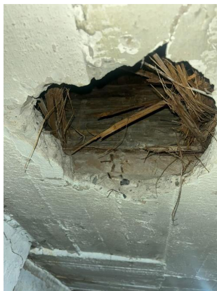
Figura 8. Auscultación de placa de entre piso
