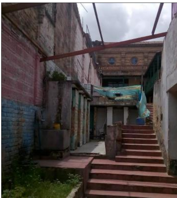
Ilustración 27. Vista de las ruinas de la zona de baños en la zona central del lote Fuente: Consorcio CEYCO-BAC
