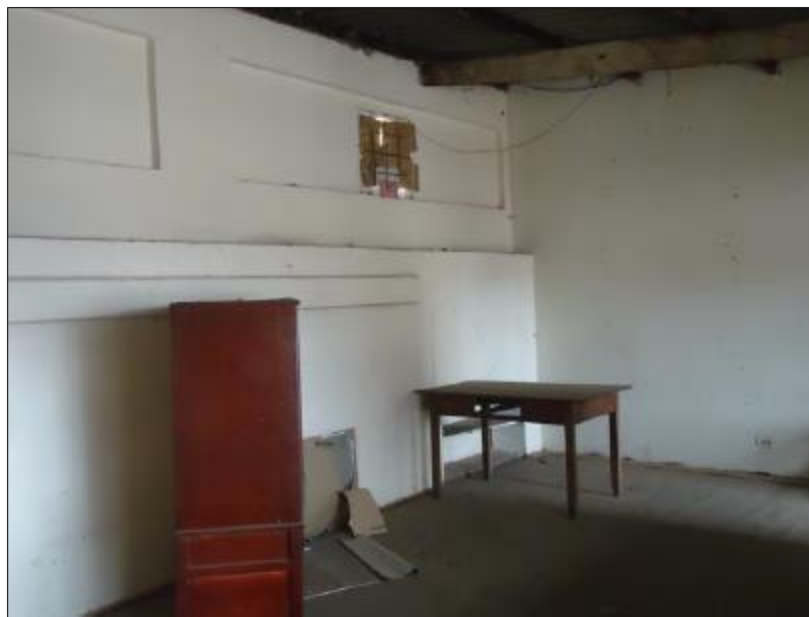
Ilustración 67. Vista del Salón E 201 hacia el muro norte Fuente: Consorcio CEYCO-BAC
