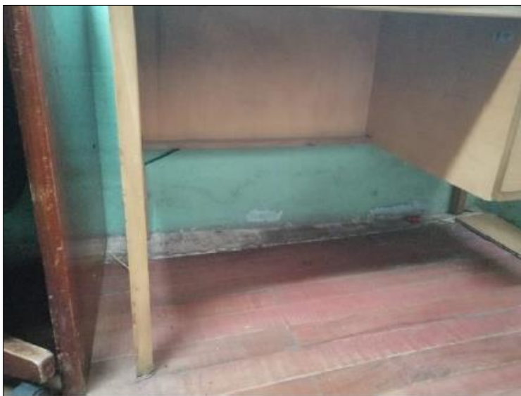
Ilustración 33. Base de muro sobre el eje A en el Salón 1 con evidencia de humedad ascendente Fuente: Consorcio CEYCO-BAC
