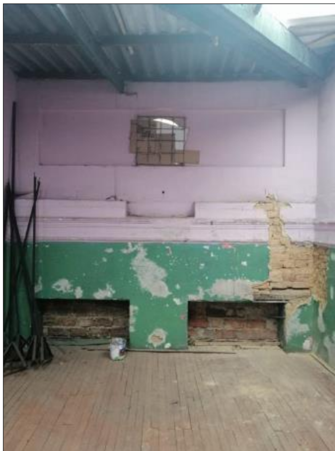
Ilustración 75. Vista del salón E 202 hacia el muro norte Fuente: Consorcio CEYCO-BAC
