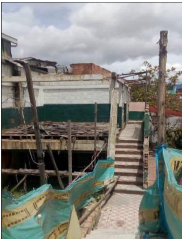
Ilustración 26. Vista de las ruinas de la construcción sur oriental del inmueble Fuente: Consorcio CEYCO-BAC
