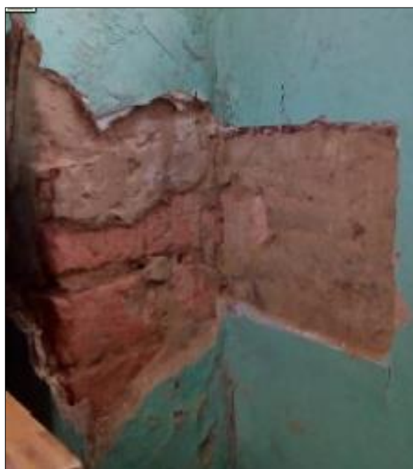
Ilustración 12. Material de columna y muros de fachada. Fuente: CONSORCIO CEYCO-BAC
