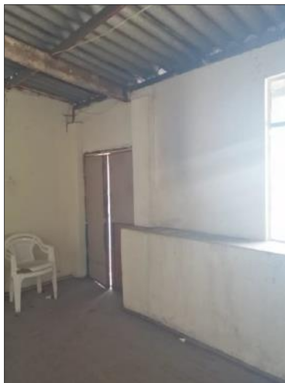
Ilustración 68. Vista del salón E201 hacia el muro sur Fuente: Consorcio CEYCO-BAC
