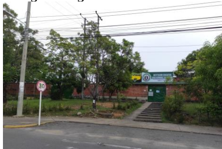
Figura 26. Fachada principal Del Colegio Diego Hernández de Gallegos
