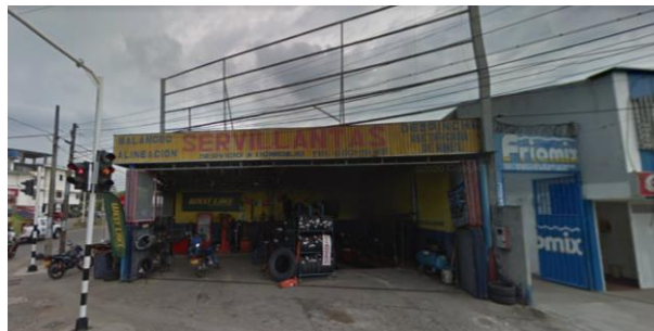
Figura 42. Fachada principal de Servillantas
