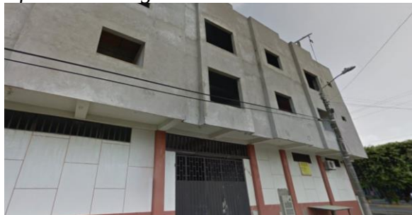
Figura 44. Fachada Sur del edificio en obra gris
