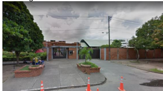
Figura 30. Fachada principal del colegio Normal
