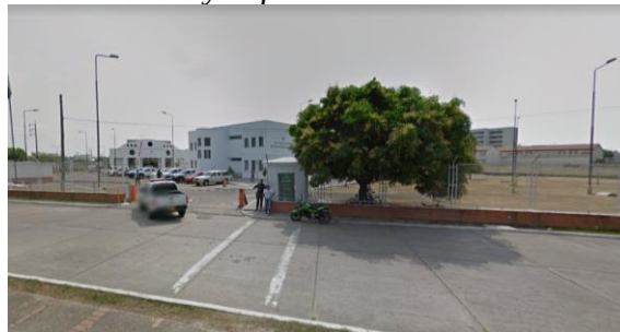
Figura 40. Fachada principal del Comando y departamento de Policía
