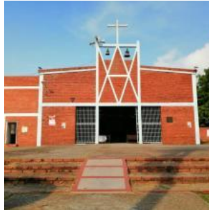
Figura 35. Fachada Norte de la iglesia Maria Auxiliadora
