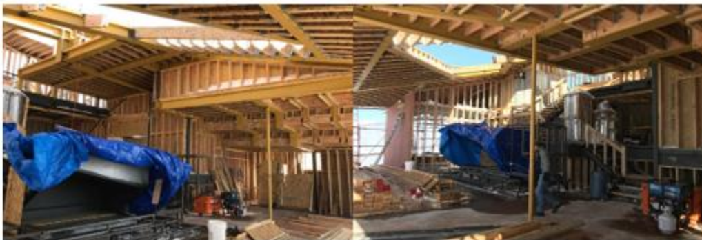
Figura 32. Estructura en madera
