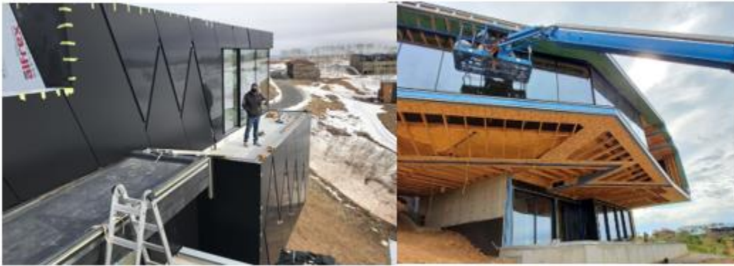
Figura 33. Instalación de paneles
