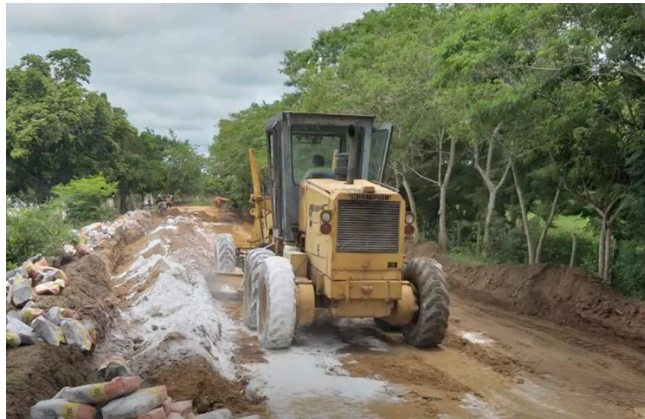
Figura 94. Mejoramiento de subrasante con cal
