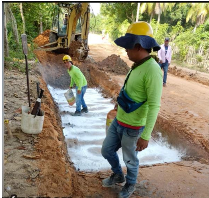
Figura 93. Mejoramiento de subrasante con cal
