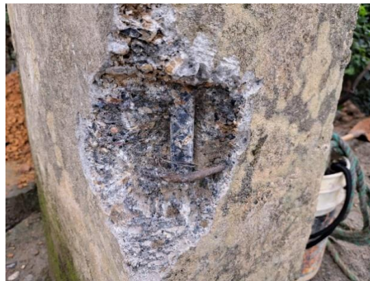
Ilustración 38 Identificación de acero 5/8" Long. Y 3/8" Trans.
