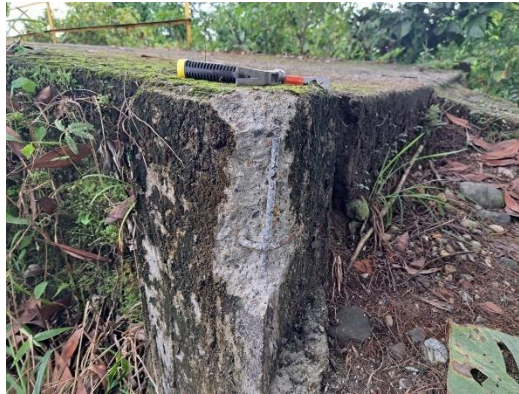
Ilustración 39 Identificación de acero 5/8" Long. Y 3/8" Trans.
