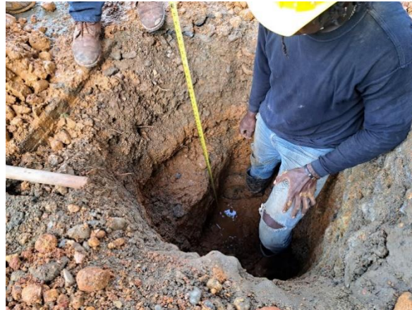
Ilustración 15 Verificación de las dimensiones de la cimentación.
