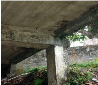
Ilustración 53 Ubicación de elementos de concreto del plan de mantenimiento
