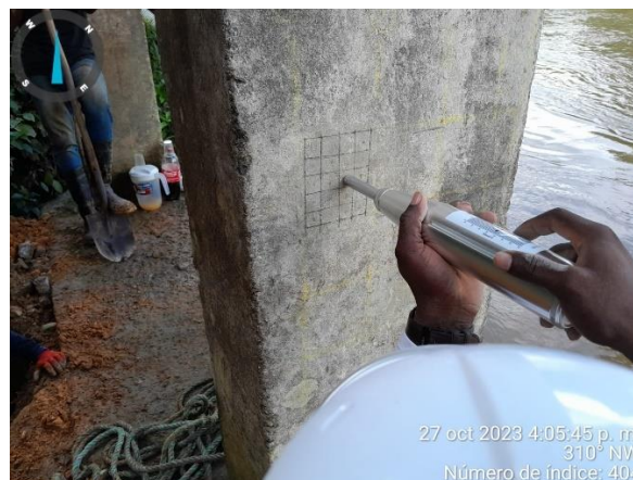
Ilustración 28 Ensayo de Esclerometría columna pórtico principal
