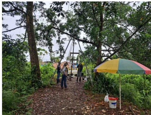
Ilustración 16 Sondeo con equipo SPT
