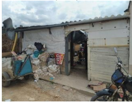
Fachada principal Vivienda
