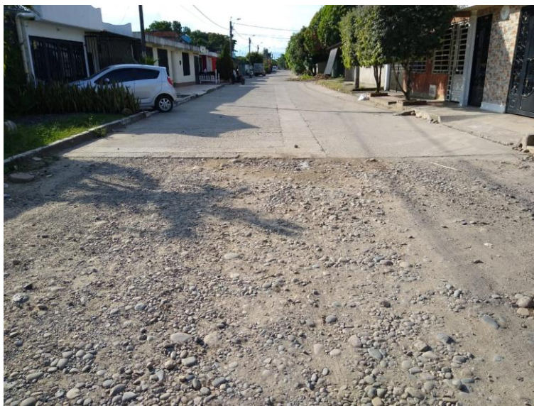
Ilustración 7-4 Inicio de estructura de pavimento, Cra 16 entre calle 10 y 11 Fuente: Elaboración propia, 2019
