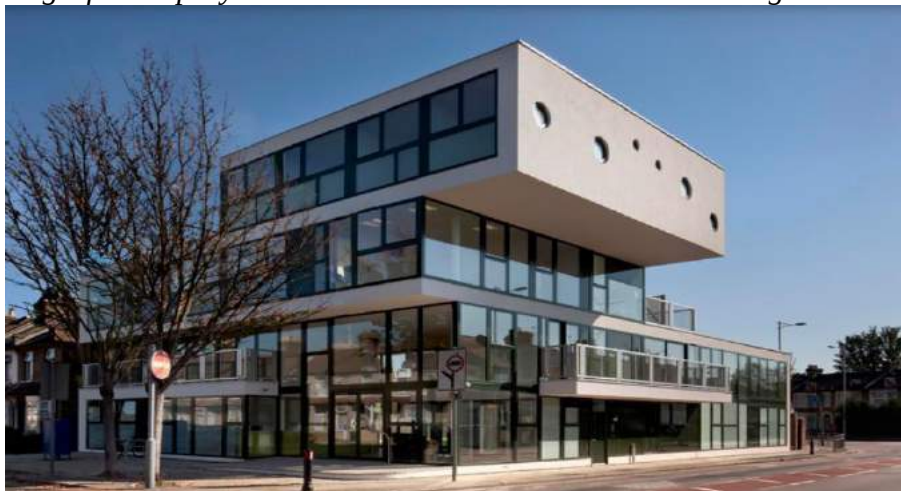
Figura 18. Fotografía del proyecto Centro de Rehabilitación de Redbridge
