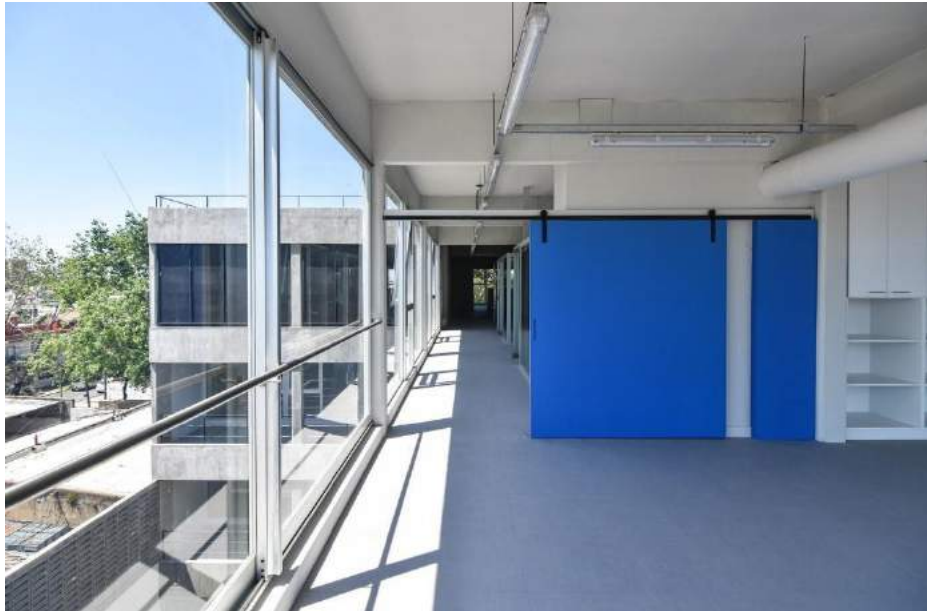
Figura 25. Representación gráfica de espacio interior Complejo municipal de rehabilitación psicofísica y saludmental.
