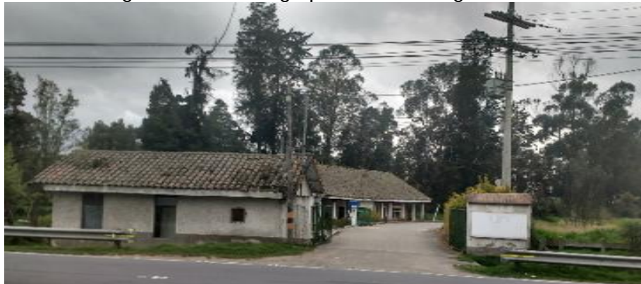
Figura 21 Centro Agropecuario Marengo.
