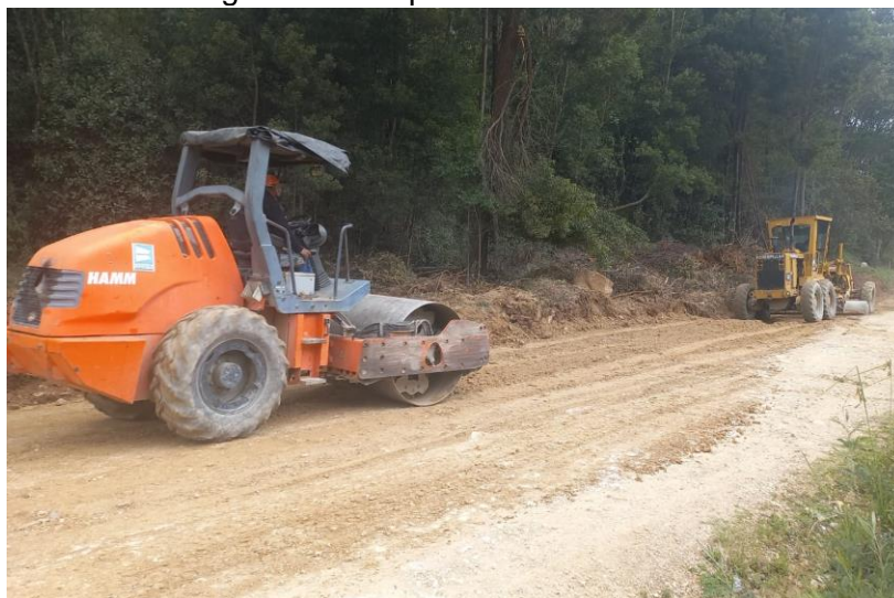
Figura 16 Compactación de material
