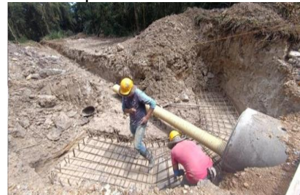
Figura 27 Figuración y amarre de acero zarpa abscisa k1+925
