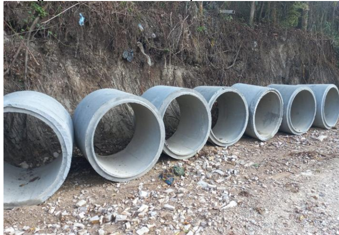
Figura 23 Tubería de 36" para las alcantarillas
