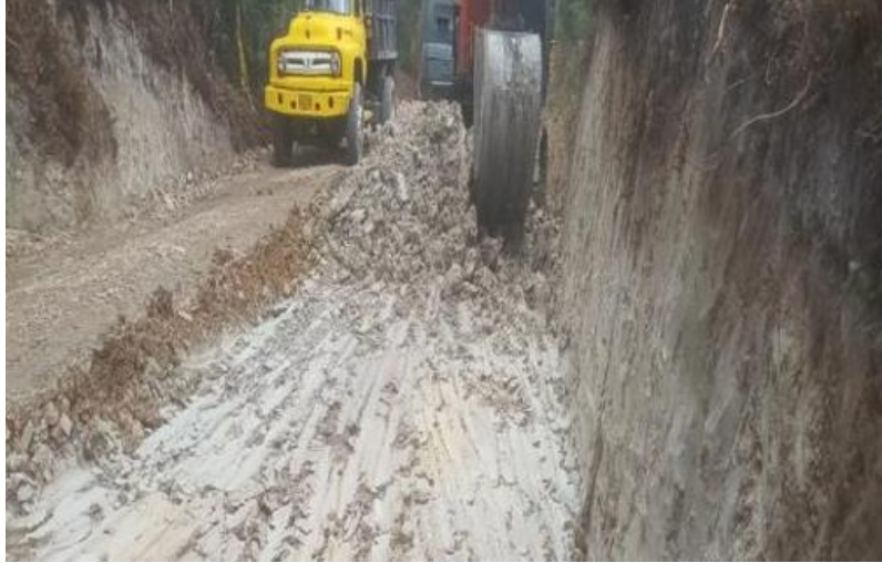
Figura 21 Material de afirmado en el Fallo
