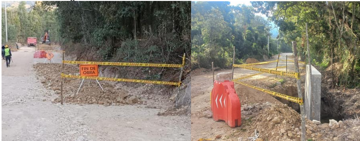
Figura 56 Señalización de los tramos intervenidos en la vía
