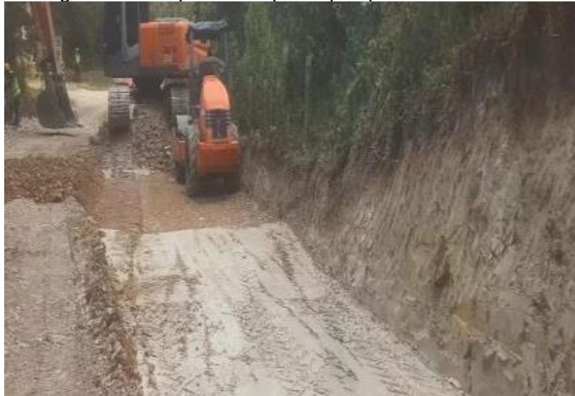
Figura 22 Compactación por capas para zona del Fallo
