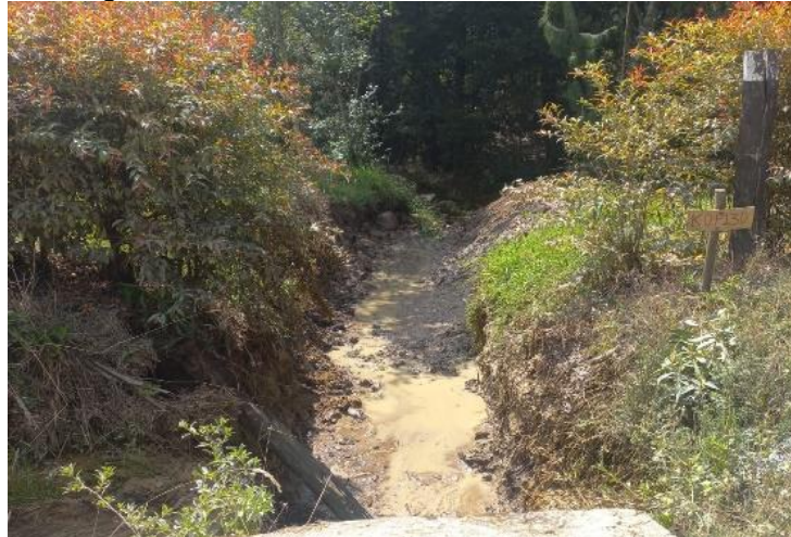
Figura 13 Excavación descole abscisa k0+130
