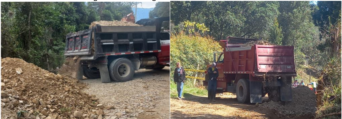
Figura 14 Descargue de material de afirmado
