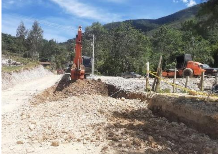
Figura 4 Excavación costado derecho
