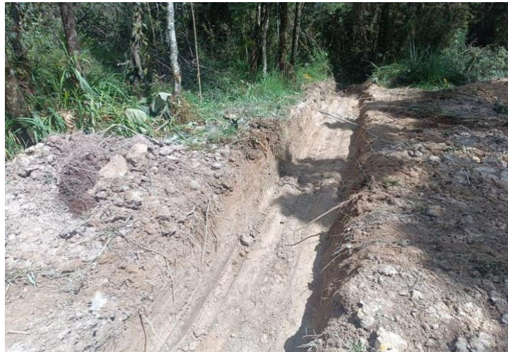
Excavación descole abscisa k1+925
