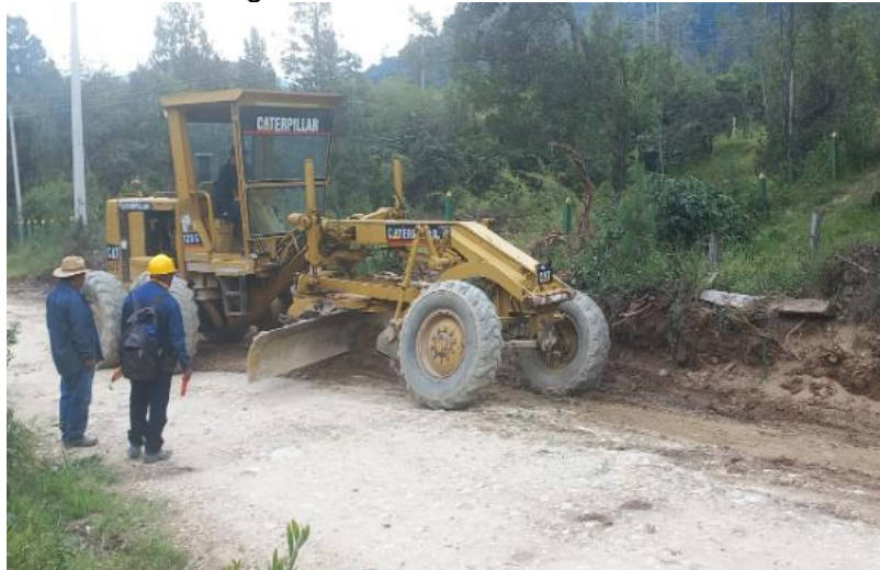
Figura 15 Extendida de material
