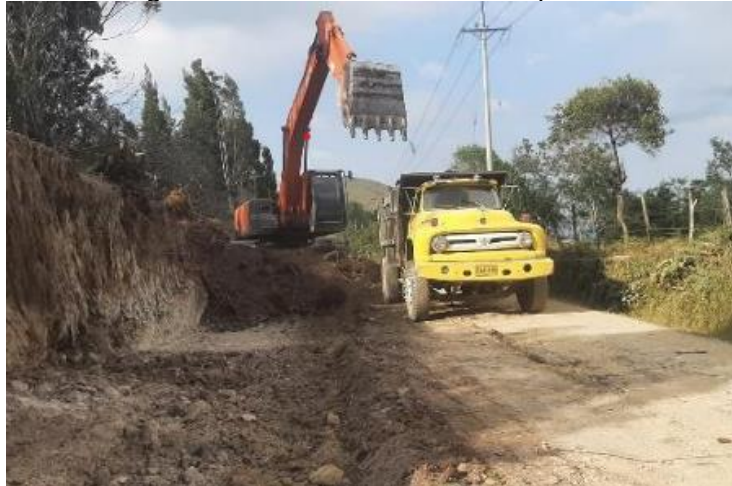
Figura 5 Excavación costado izquierdo
