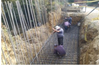
Figura 24 Figuración y amarre de acero zarpa y muro abscisa k0+400
