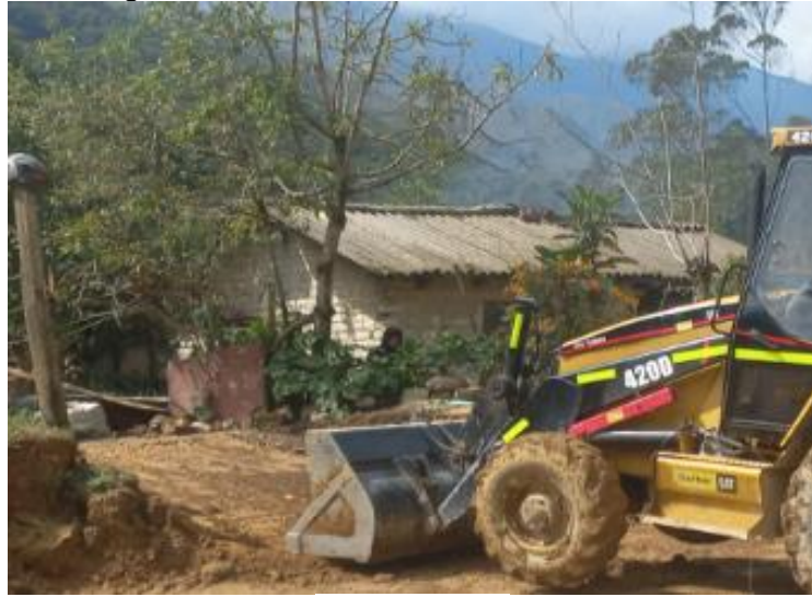
Figura 57 Adecuación entrada vivienda local
