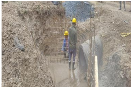
Figura 26 Figuración y amarre de acero muro abscisa k1+925
