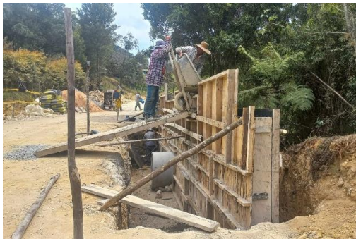
Figura 37 Fundida muro en la abscisa k0+400
