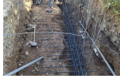
Figura 25 Figuración y amarre de acero zarpa y muro abscisa k0+880
