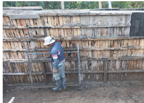
Figura 38 Encofrado muro en la abscisa k0+880
