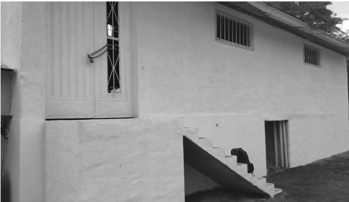
Figura 15. Caseta de almacenamiento de agua tratada y agua cruda Fuente: Autores.
