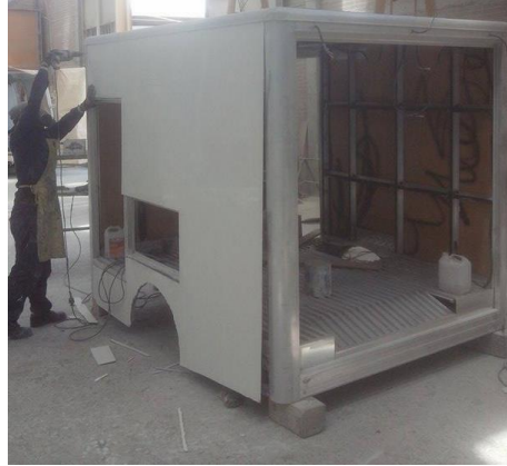
Figura 4 Ensamble de láminas en fibra de vidrio a la estructura de la carrocería.
