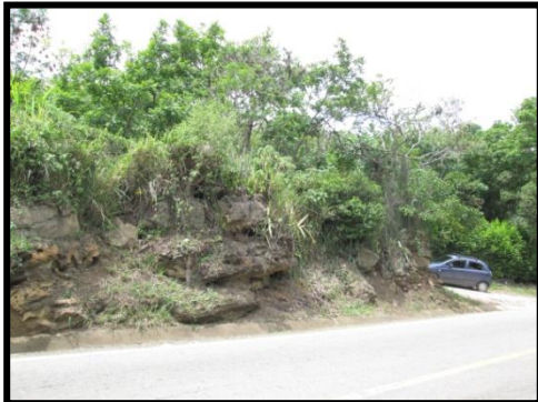
Figura 12. Vista vía San Gil
