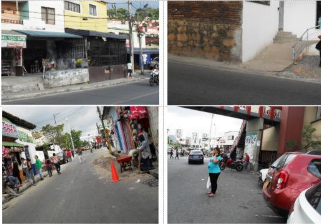
Figura 35. Andenes inferiores a 1m. de ancho
