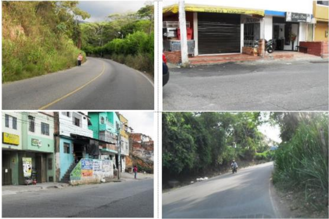
Figura 34. Tramos sin andén
