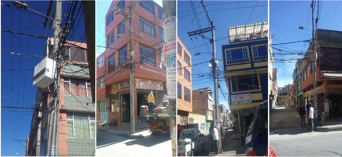
Figura 7 Obstrucciones visuales para las cámaras.
