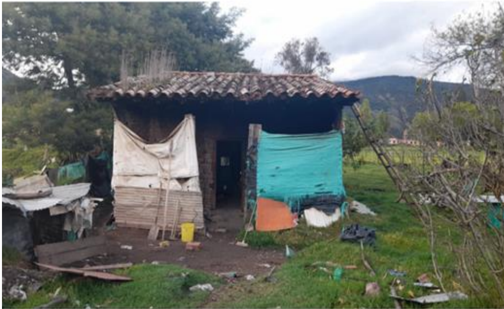
Figura 38. Vivienda con material predominante de adobe.
