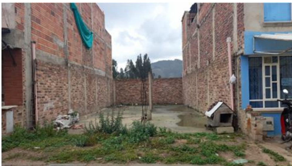
Figura 32. Vivienda en proceso de construcción.
