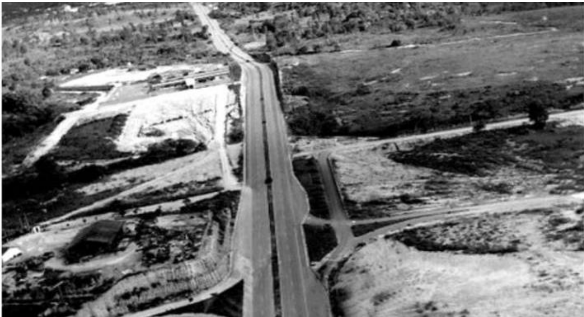
Figura 29. Autopista Bucaramanga Floridablanca 1960. Vía importante creada como integradora de los dos municipios pensando en una expansión urbana futura. Fuente: Carlos Eslava
