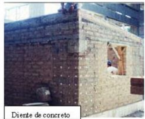
Figura 11. Secuencias de reforzamiento de estructura
