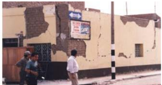
Figura N°9 Fallas típicas en construcciones de adobe por acción sísmica perpendicular al plano de los muros: desgarramiento vertical en las esquinas y grieta vertical por flexión en la zona central del
