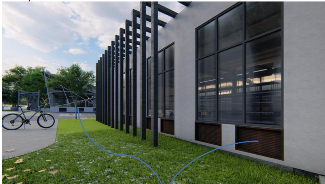
Figura 41. Deflectores de ventilación
