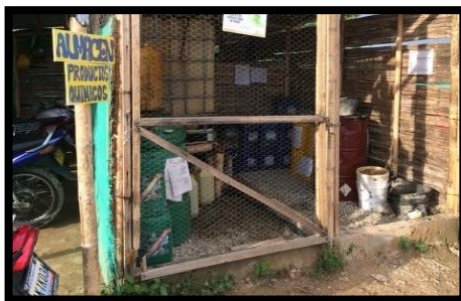
Figura 7. Almacenamiento temporal de productos y/o sustancias químicas en obra civil
