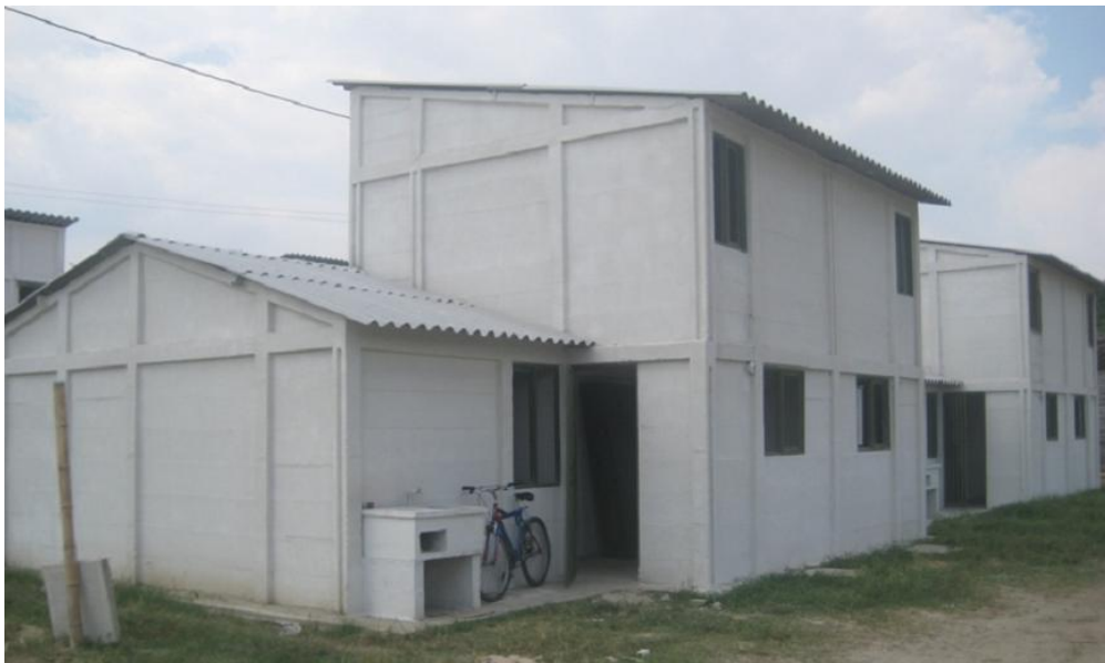
“Pre fabricados de Eco Hormigón” FOTO 6
