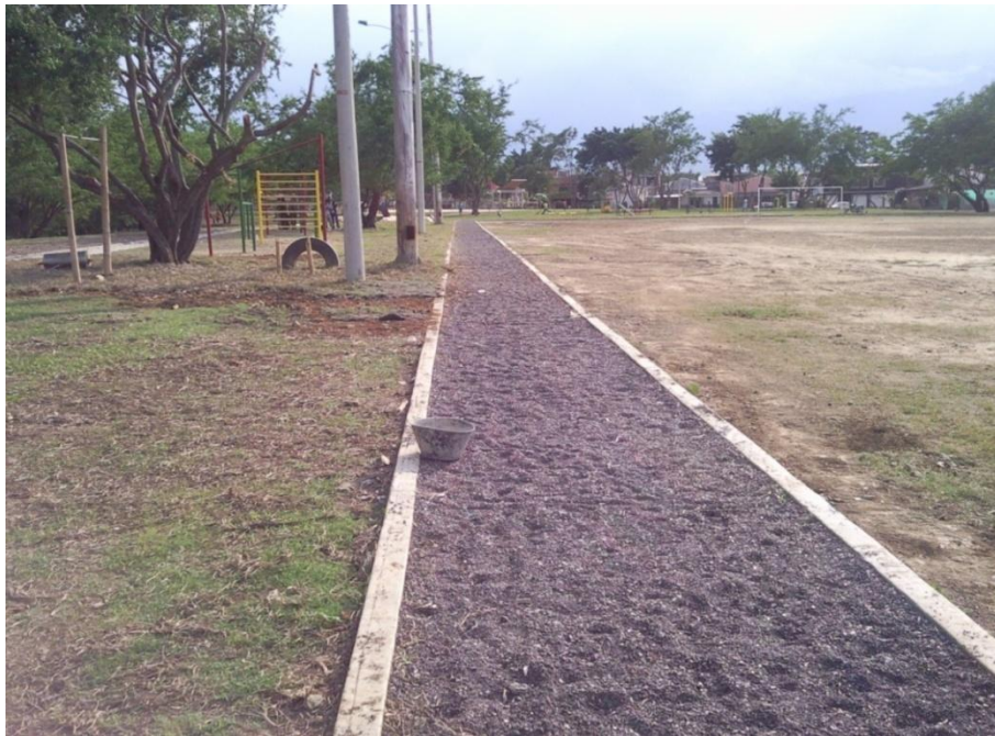
FOTO 10 RECORRIDO PEATONAL CON DESECHOS DE MATERIAL MINERAL (COBRE)
