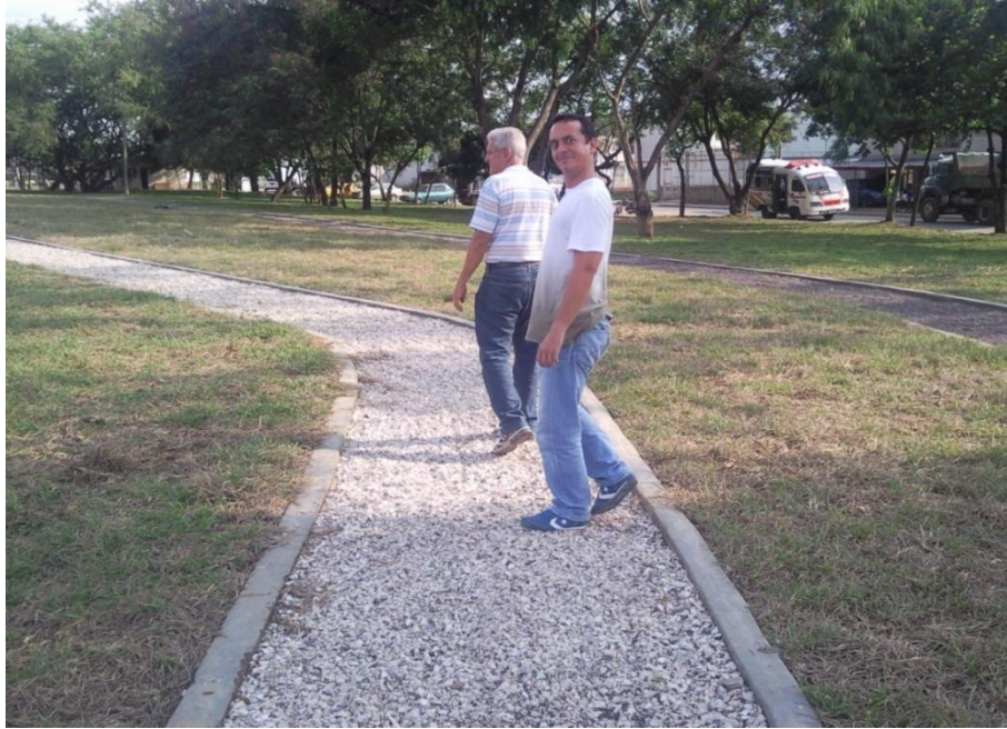
RECORRIDO PEATONAL CON DESECHOS CERÁMICOS RECICLADOS DE TRANSFORMADORES ELÉCTRICOS
