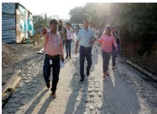
GOBERNADOR INSPECCIONÓ OBRAS DE MEJORAMIENTO VÍA CUEVA DE LOS MICOS- LA REPRESA
