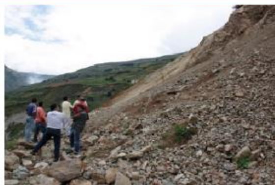
EL SECRETARIO DE INFRAESTRUCTURA VISITÓ EL CORREDOR VIAL DEL MUNICIPIO DE SILOS
