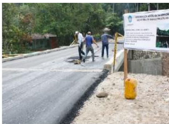
SECRETARÍA DE VÍAS E INFRAESTRUCTURAS HABILITO PUENTE GUAYABALES
