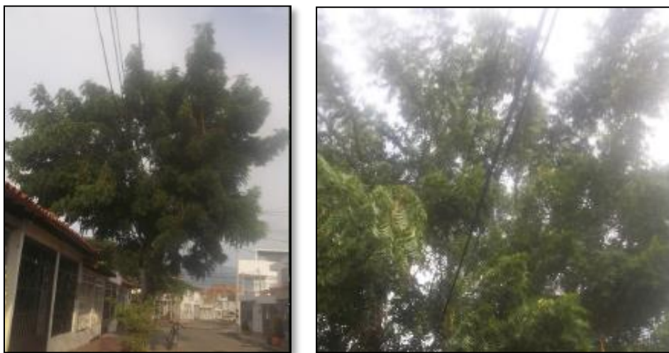
Figura 45. Poda bajo cables trenzados
