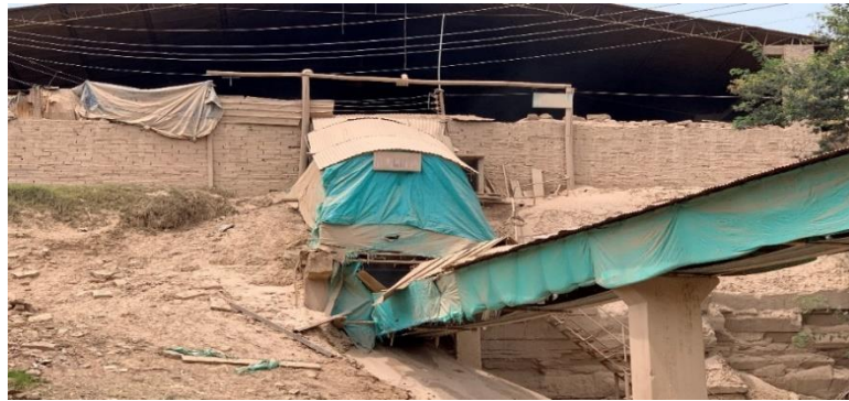
Ilustración 4. Zona de molienda y paso de materia prima a banda transportadora. Ladrillera El Rubí S.A.S
