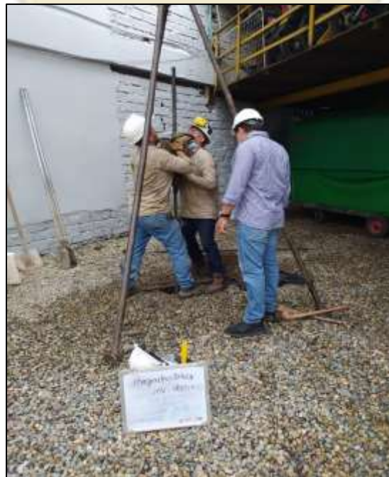
Ilustración 3 Localización del sondeo realizado parqueadero Bolívar
