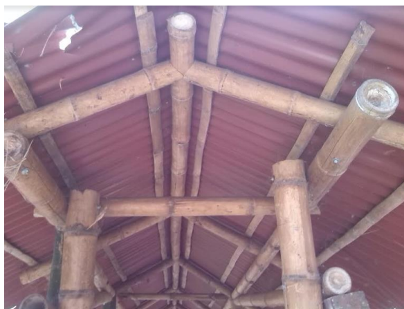
Figura 3. Vista transversal del puente de la finca El Centenario
