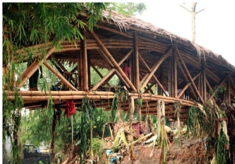
Figura 12. Puente en guadua Davao, Filipinas
