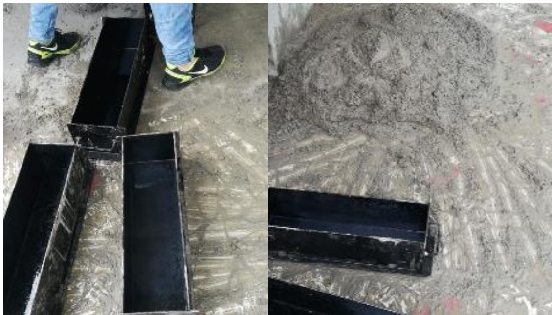
Figura 22 Llenado encofrado viguetas Fuente: Propia
