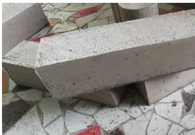
Figura 26 Desencofrado de viguetas Fuente: Propia
