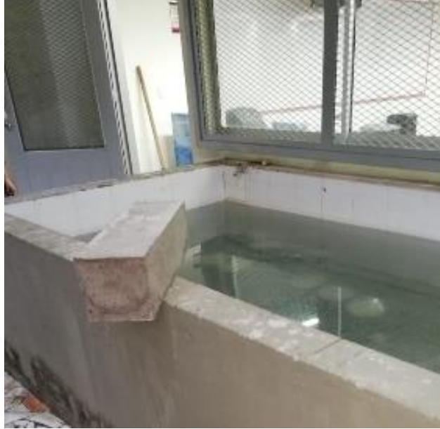
Figura 27 Desencofrado de viguetas Fuente: Propia
