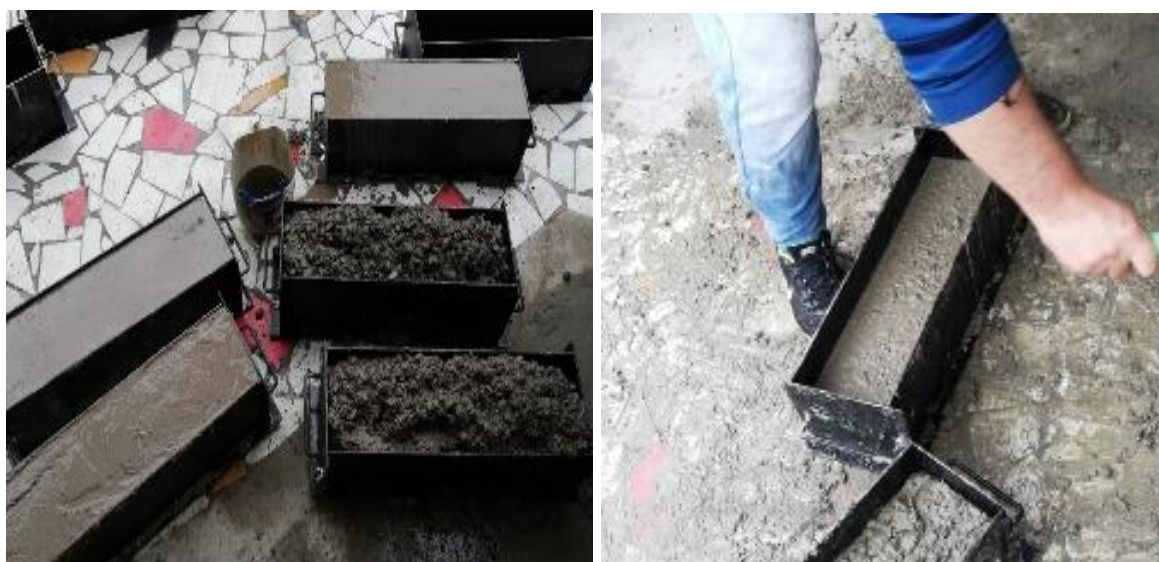
Figura 23 Llenado encofrado viguetas Fuente: Propia
