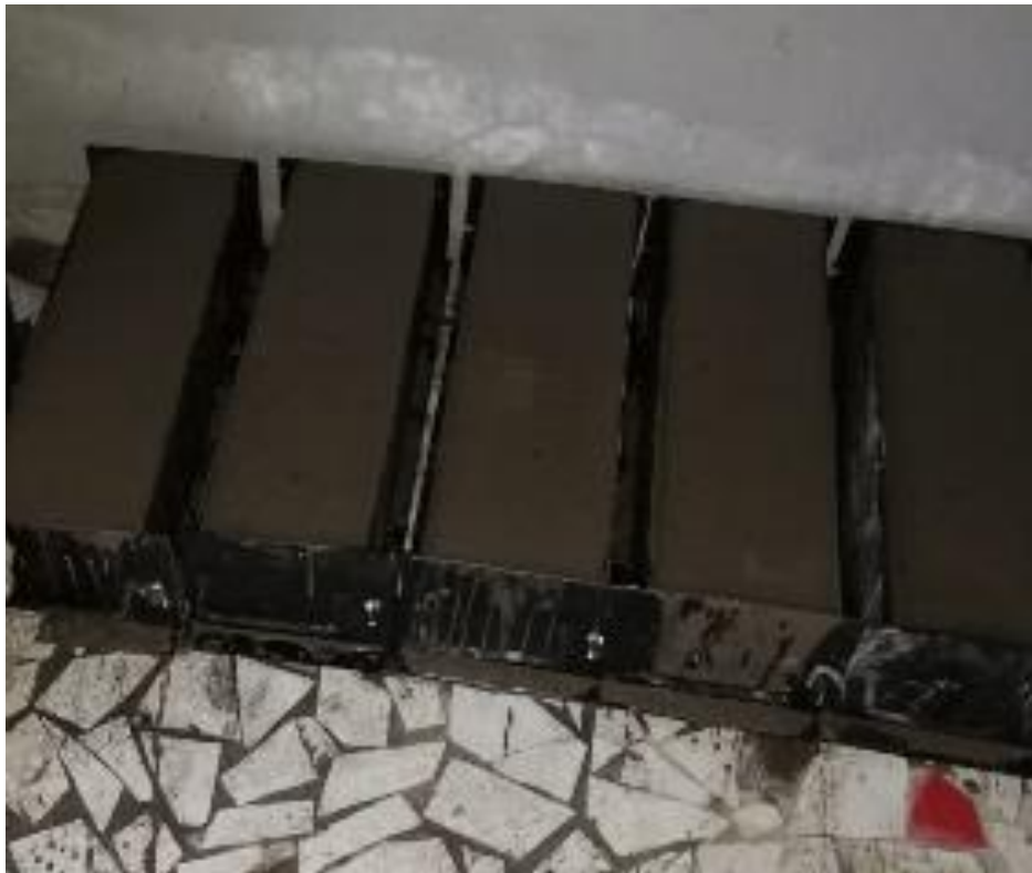
Figura 21 Encofrado viguetas almacenadas 24 horas.
