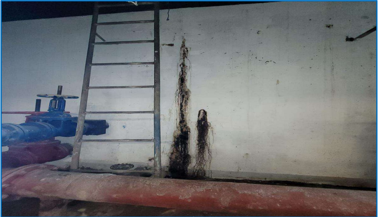
Fotografía 7: Lesión de humedad por filtración, generando afectación por ataque biológico y químico generando eflorescencia en el elemento afectado, esta lesión se ubica en el muro interno de los tanques de almacenamiento de agua en el sótano.
