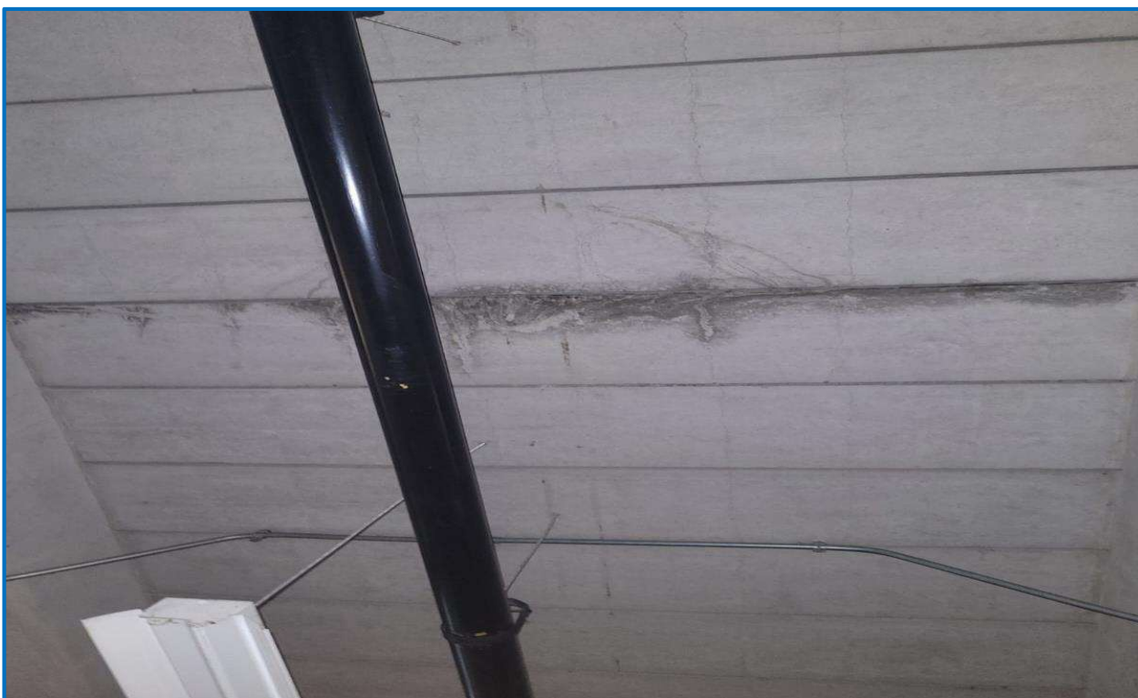
Fotografía 1: Lesión de humedad por filtración, generando afectación por ataque biológico y químico generando eflorescencia en el elemento afectado, esta lesión se ubica en la placa entre el sótano y el semisótano.
