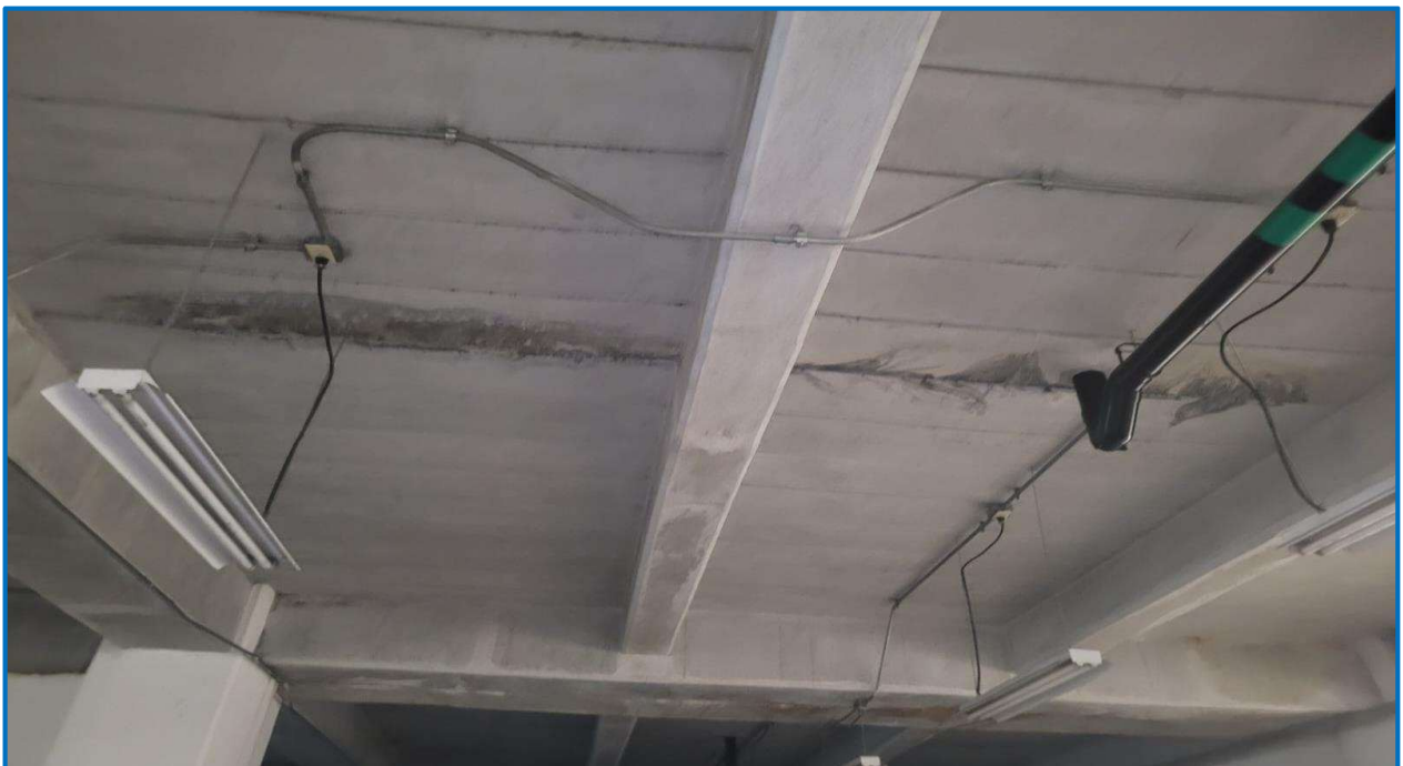
Fotografía 3: Lesión de afectación mecánica, donde se evidencia una deformación en el elemento afectado, ubicada en la placa entre sótano y semisótano.
