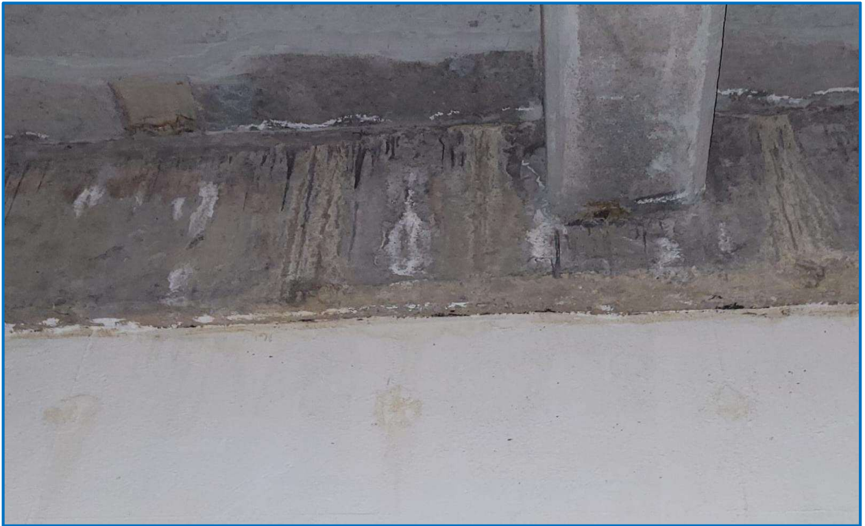
Fotografía 5: Lesión de humedad por filtración, generando afectación por ataque biológico y químico generando eflorescencia en el elemento afectado, esta lesión se ubica en la placa entre el sótano y el semisótano.
