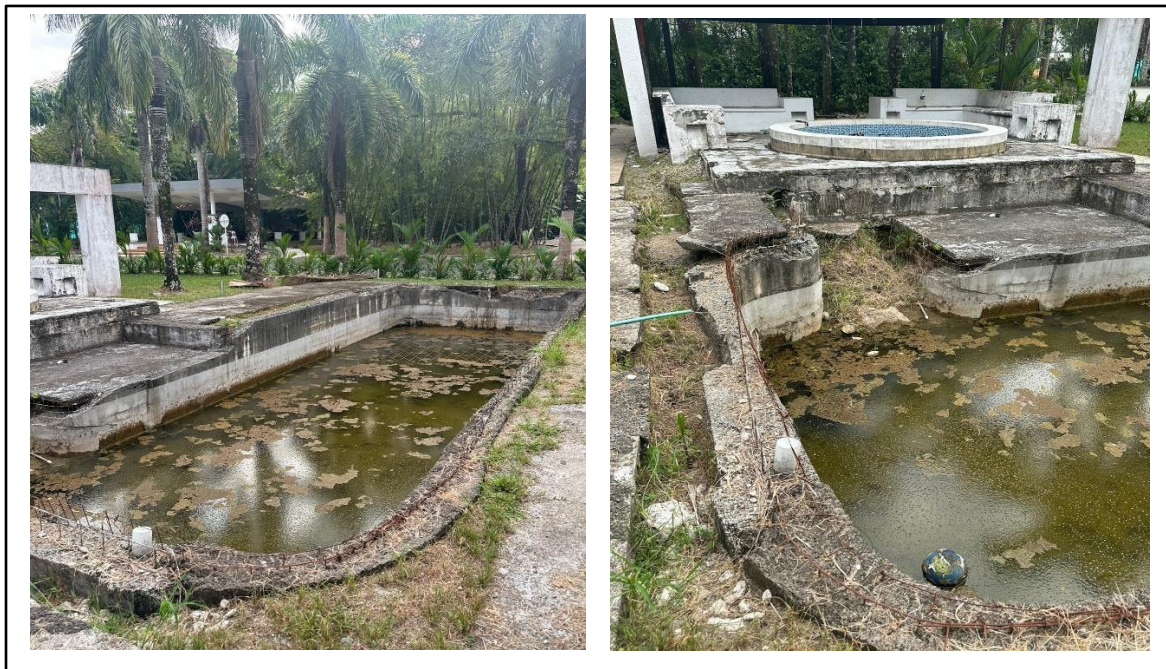
Figura 31. Estado Actual de la piscina – Casa No. 05 Condominio Barú (Fuente Propia)
