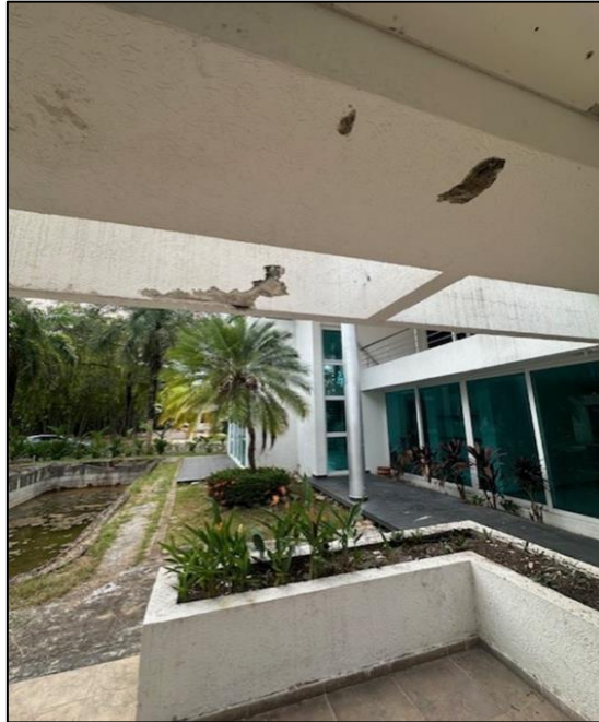
Figura 8. Fotografía estructura de cubierta de los parqueaderos desde el acceso de la calle.
