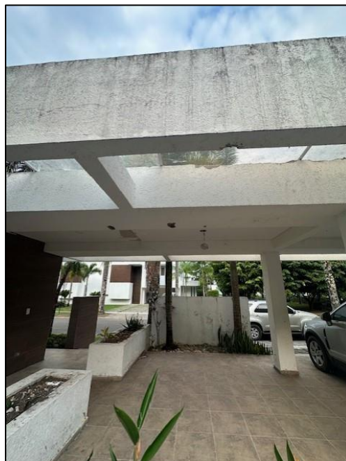
Figura 9. Fotografía estructura de cubierta de los parqueaderos desde la piscina. (Fuente
