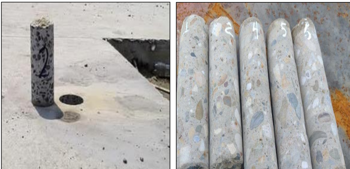
Figura 40. Extracción de núcleos de concreto (fuente propia)
