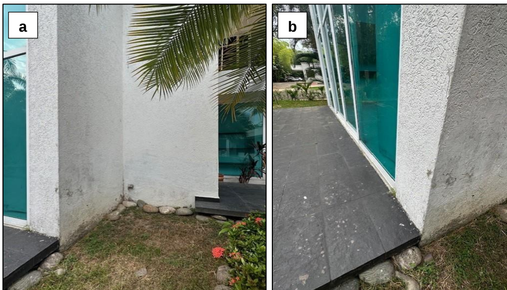
Figura 13. Fotografía estado actual del exterior. (Fuente propia)
