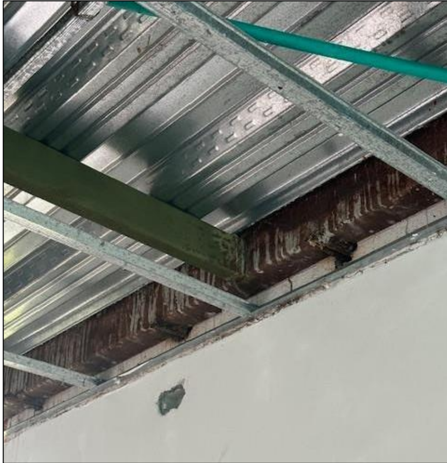
Figura 26. Fotografía detalle del estado actual muros internos, cielorraso primer piso y estructura de la placa de entepiso piso 2. (Fuente propia)
