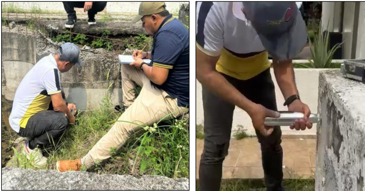
Figura 39. Realización prueba de esclerometría (fuente propia)
